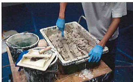
➔③ 9/14 下塗り漆喰作業
