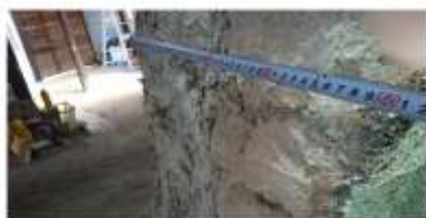
寸版窯構壁の厚さ50cmにもなる一保温と密閉効果が高まる
